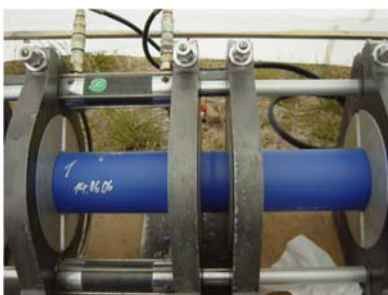
Bild 1: Verschweißen von PE-Rohren (Stangen zu je 12 m)
