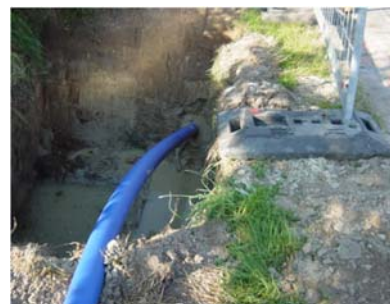
Bild 4: Einzug einer PE-Leitung mit Durchmesser d = 110 \text{ mm}
