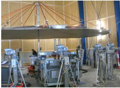
Abb. 6: Angehobenes Kegeldach für einen Edelstahltank, Vorbereitung Mantelschweißung
