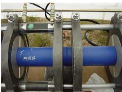
Bild 1: Verschweißen von PE-Rohren (Stangen zu je 12 m)
