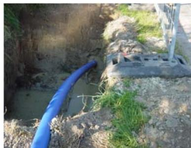
Bild 4: Einzug einer PE-Leitung mit Durchmesser  $d = 110$  mm
