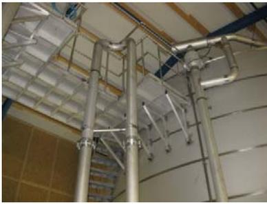
Bild 3: Neuer Trinkwasserspeicher am Wasserwerk Föhr-West (Edelstahltanks 2 × 400 m³)
