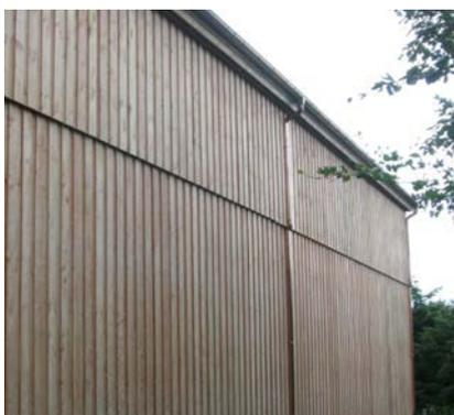
**Abb. 5:** Halle von außen mit Lärchenholzverkleidung in Boden-Deckel-Schalung
