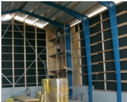
**Abb. 3:** Hallenbau in Stahlträgerkonstruktion mit Wandisolierung (Glaswolle)
